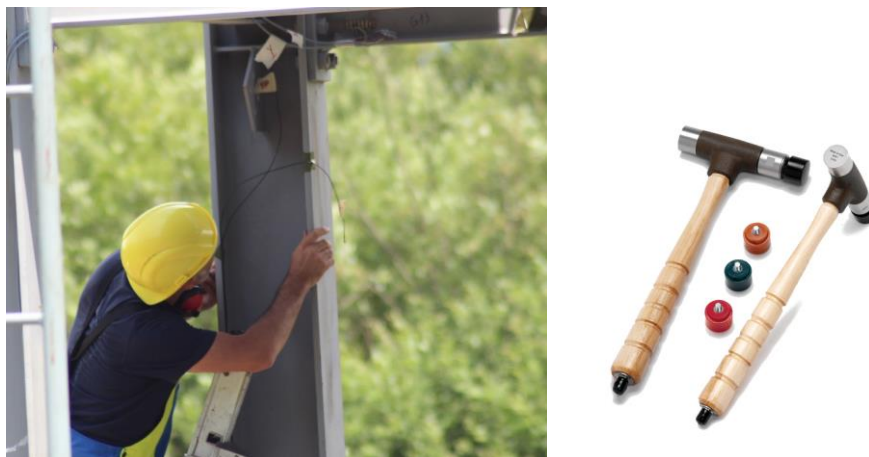
Fig. 2 Montarea accelerometrelor pe structura metalica (stanga) si sursa de excitare - ciocan cu senzor de forță de tip 8208
