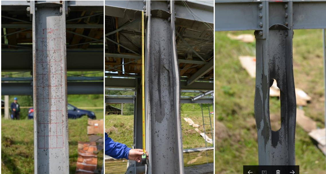
Fig. 8 Vedere cu stalpul central dupa teste E4, E5 si E6
